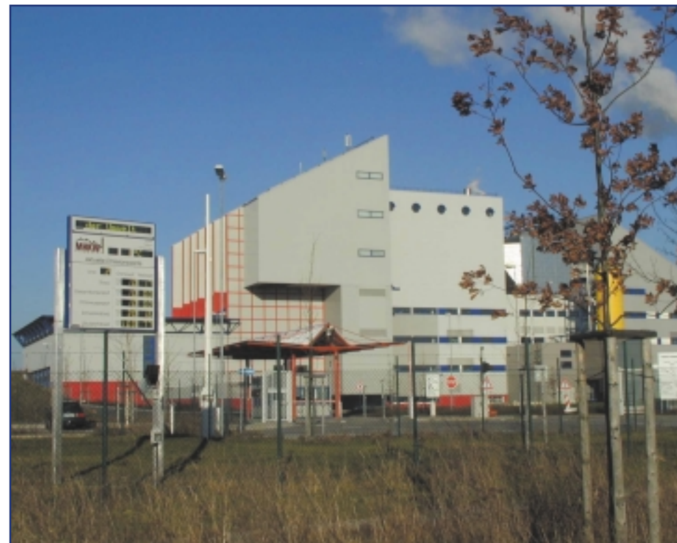
Ansicht MHKW Pirmasens der Firma SOTEC mit Emissionsanzeigetafel
