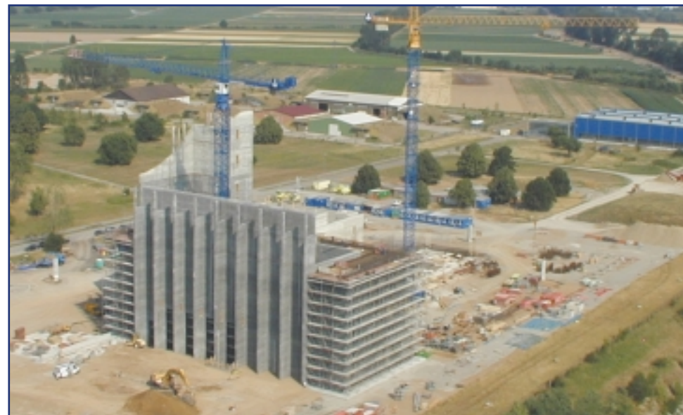
Luftbild der Baustelle 6/2003
